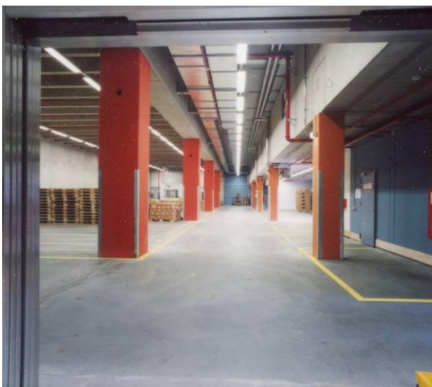
Distribution im Erdgeschoss
